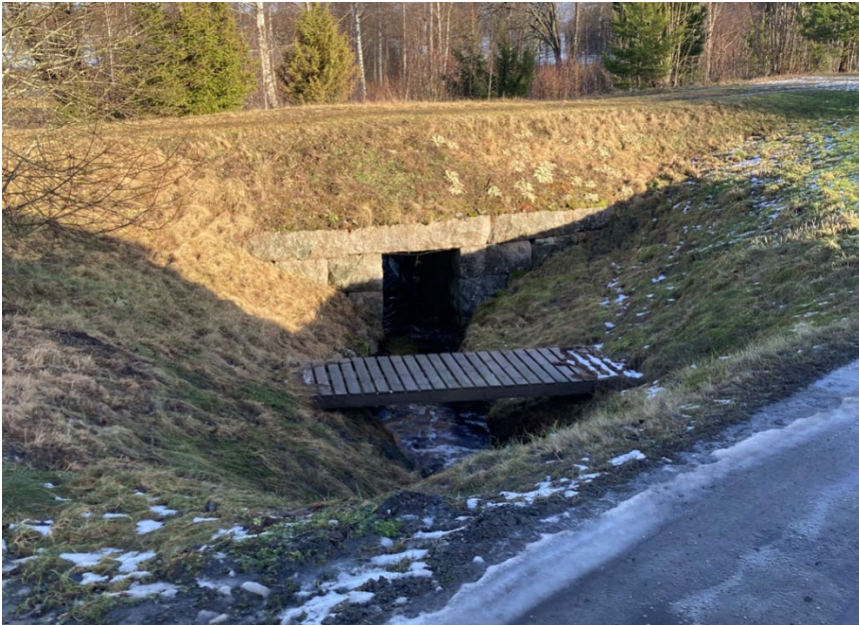
Figur 14. Viadukten under tidigare järnvägen
