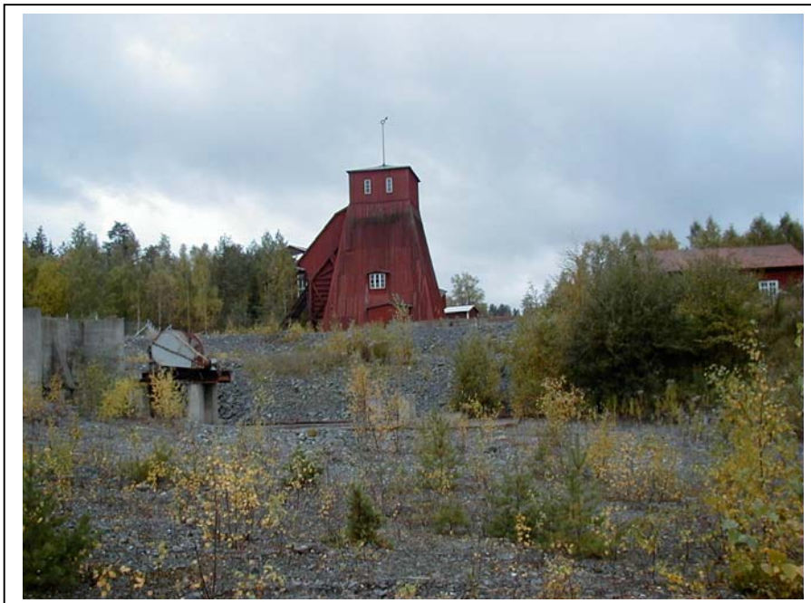
Storgruvans lave och maskinhus.
