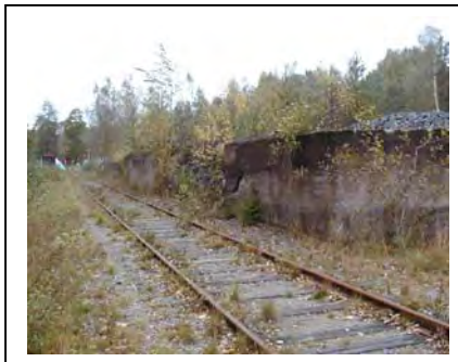
Det gamla plockverkets grund ligger väster om spåret.
