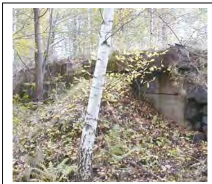
Resterna efter perrongen av betong finns kvar under alla löv och träd.
