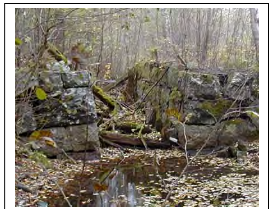
Resterna av turbinhuset
