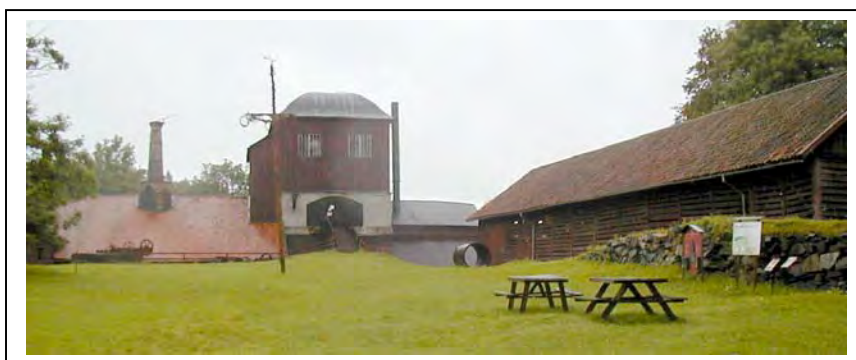
Hyttan med masugn t.h. och rostugn t.v. På bilden syns även det stora kolhuset.
