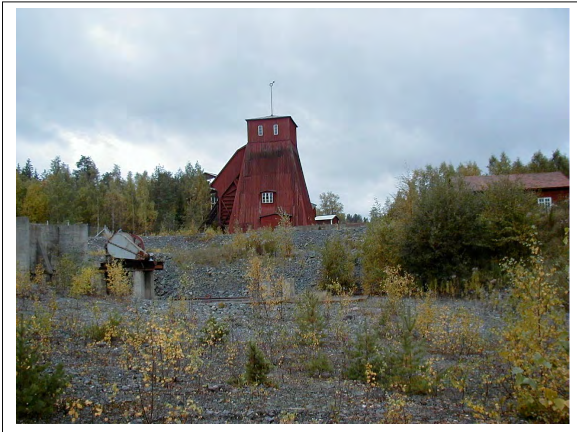
Storgruvans lave och maskinhus.
