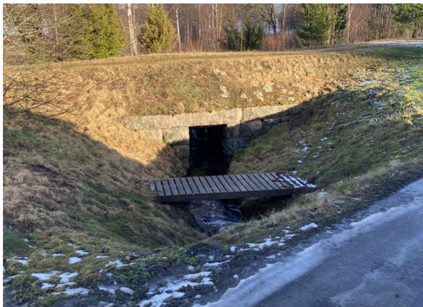
Figur 18. Viadukten under tidigare järnvägen
