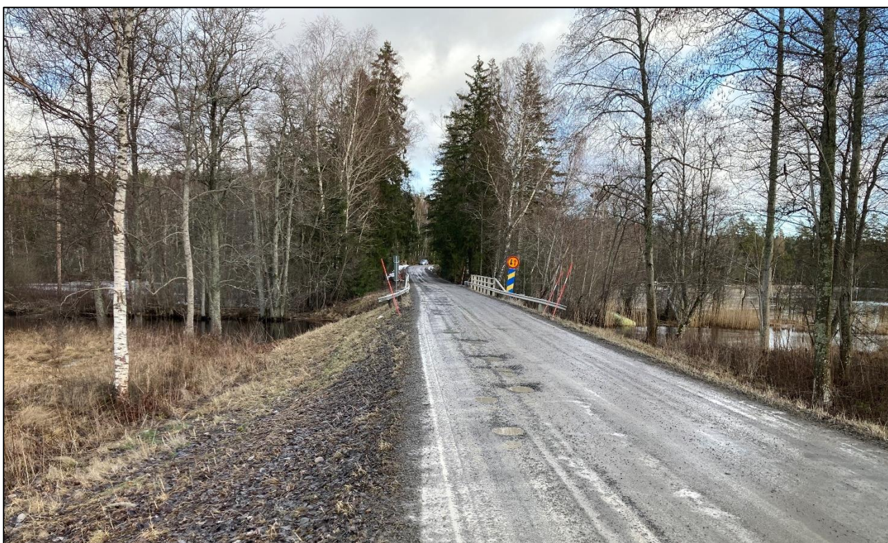
Figur 16. Bro längs väg 742. Foto: WSP, 2025.
