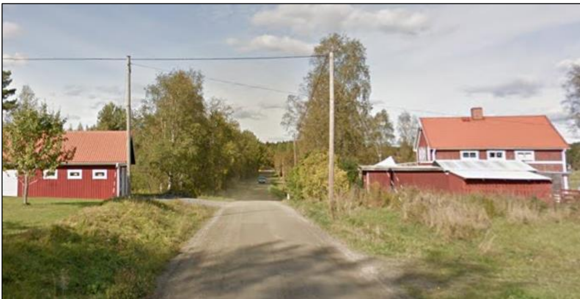
Figur 14. Byggnad ca 15 meter (till höger) från vägmitt. Foto: Google maps.
