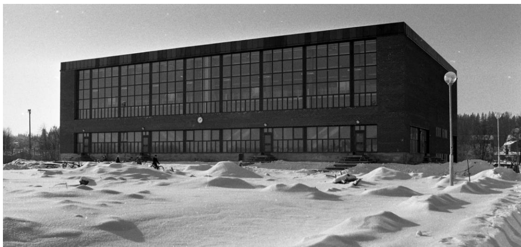
Idrottshuset sett från öster 1968 (Örebro länsmuseum).
