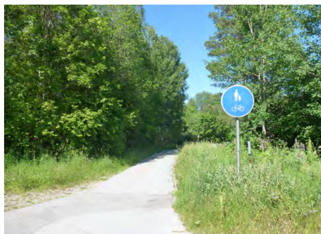
Gång- och cykelväg i Ås
